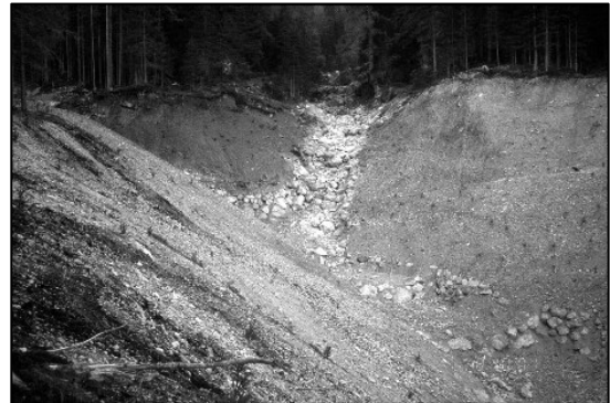
Fig. 10 e 11: sistemazione della zona d'innesco e di propagazione della colata con opere miste in massi e calcestruzzo armato.
